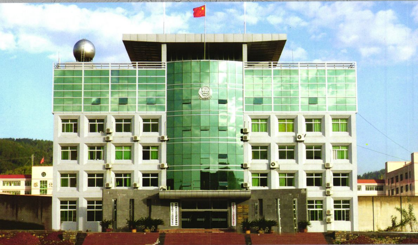
▲ 2004年5月，新竣工的办公大楼。
