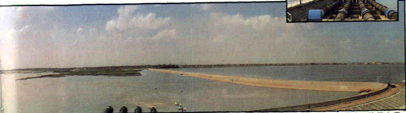
上海原水股份有限公司长江原水厂陈行水库
