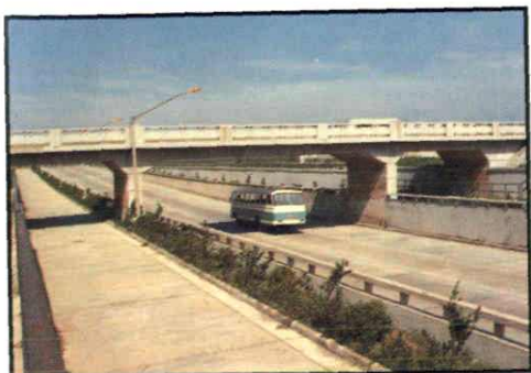
富锦路立交桥
