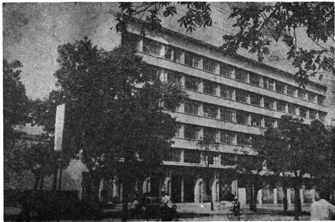
建设公司综合楼
