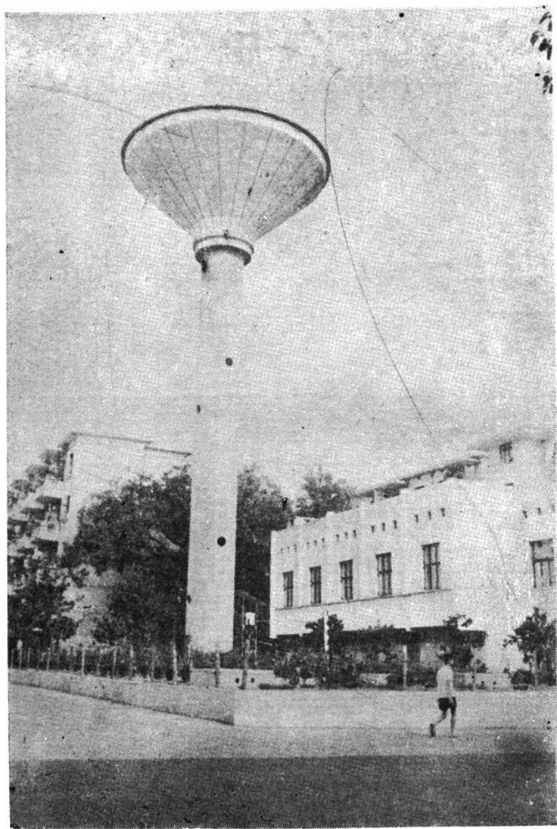
钢筋混凝土倒锥壳水塔
