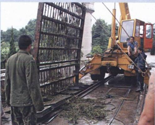
▲ 引江抽水机站设拦污栅, 阻止钉螺随漂浮物扩散
