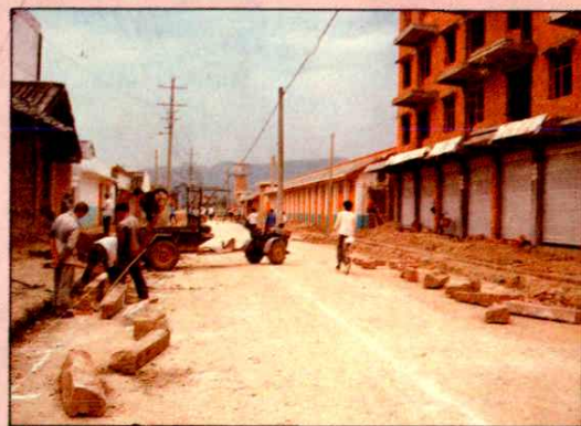
建設中的翠雲路西段
