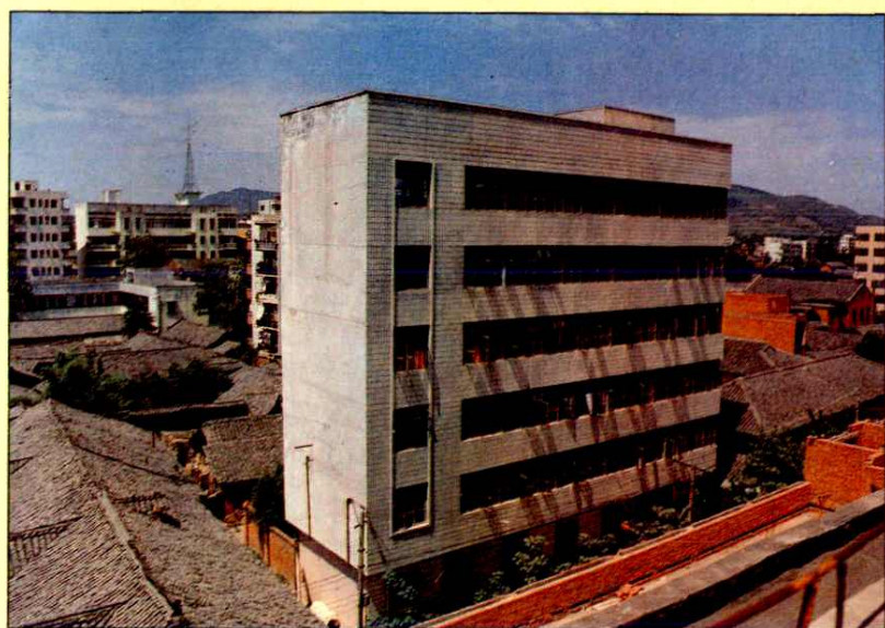
梓潼縣城鄉建設環境 保護局辦公大樓
