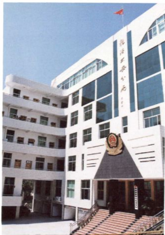
龙港分局办公大楼
