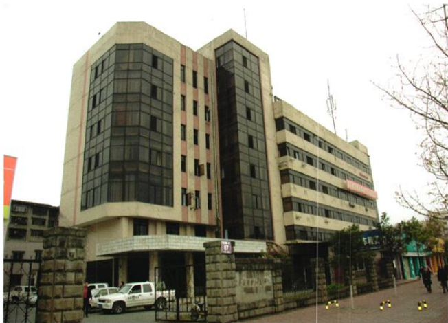
德阳市规划和建设局原办公大楼
