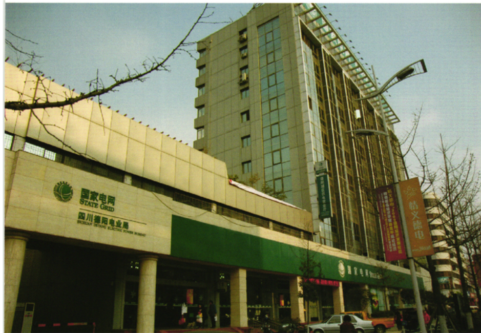
德阳市电力局调度大楼
