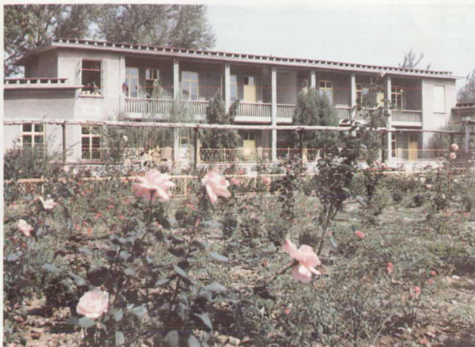
质量检查科化验楼
