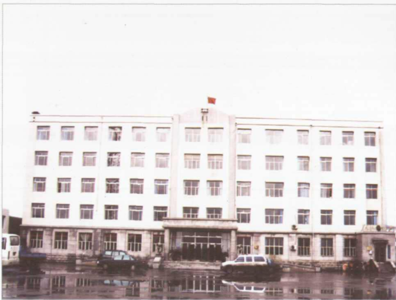
现奋进乡政府办公楼 (新月路 66号)
