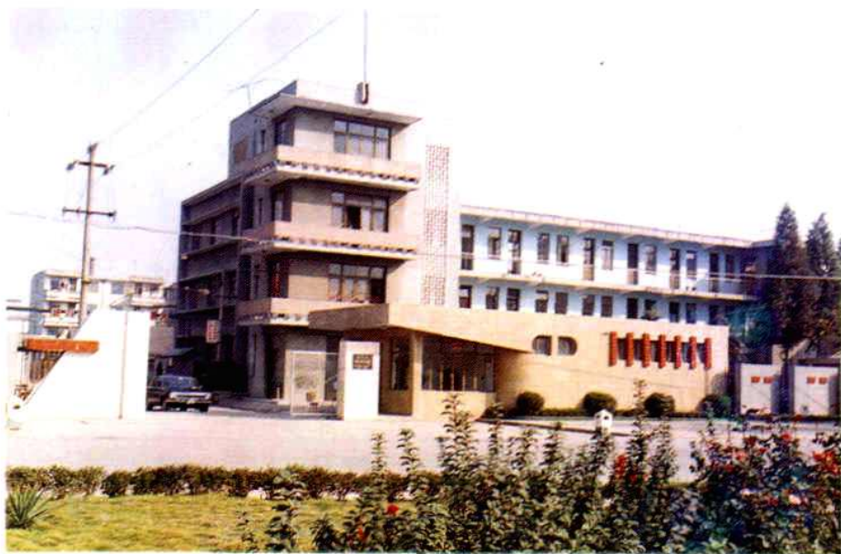
县植物油厂办公楼
