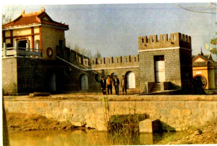
旧城遗址·海南排灌站
