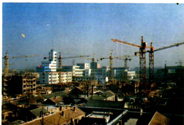
建设中的鱼台
