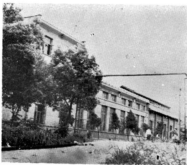
机电设备维修车间
