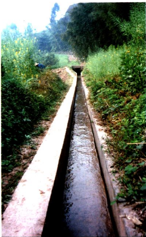
2000年实施永兴小流域水土保持治理工程时整治的永兴分支渠
