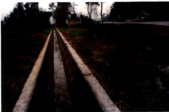
1991-1992年整治衬砌的双河一支渠
