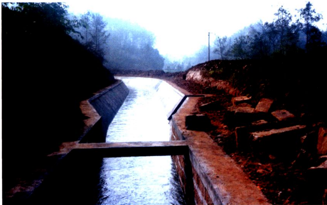
2002年11月第一期节水改造项目整治后的名左渠建山段的部分渠段
