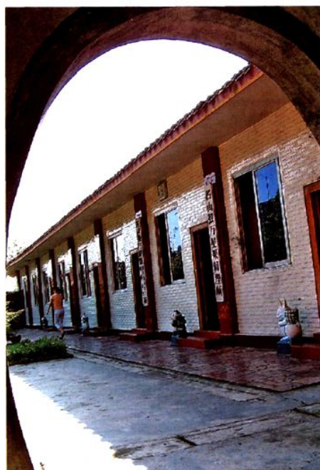
1998年，整修后的万星渠管理所
