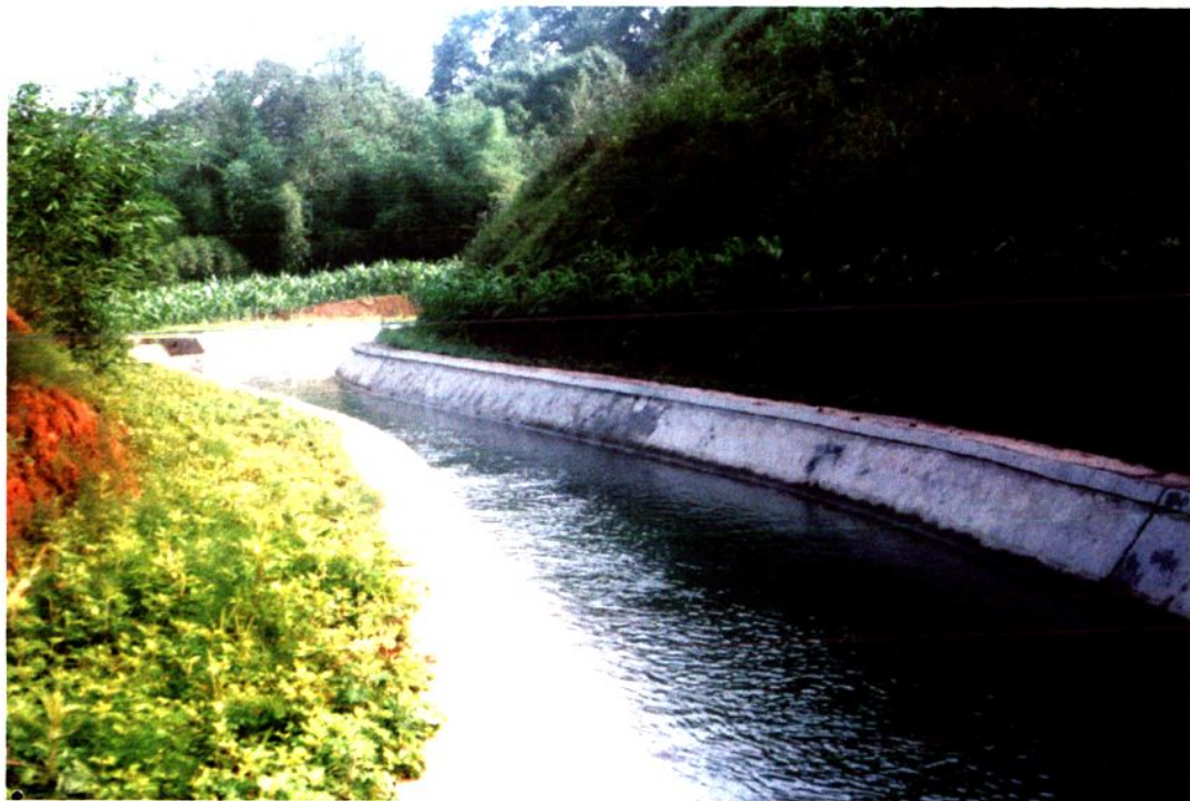
2003年第三期节水改造项目整治后的名左渠白土坎段的一渠道
