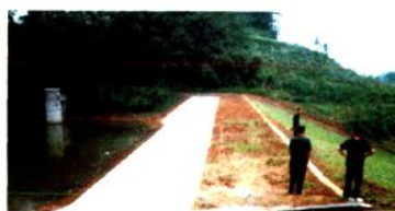
2005年7月，整治栓马沟水库大坝和竖井
