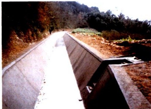
2003年12月完成的第二期节水改造项目整治后的名左分干渠余广坡渠段
