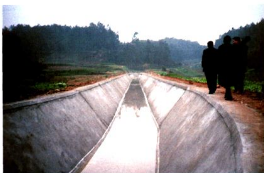
试点工程项目完成的万星分干渠上段（何家沟段）
