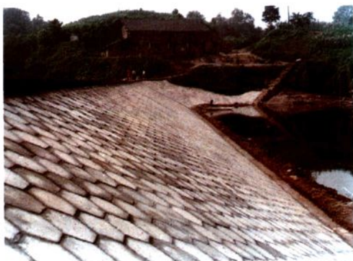
1997年10月，翻筑土坝、土工膜防渗、六方预制板护坡后的高炉沟水库大坝
