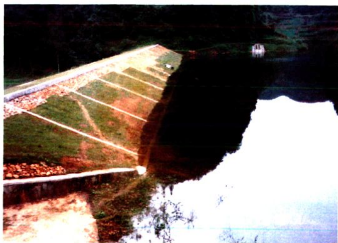
2003年10月，整治后的梅沟水库大坝
