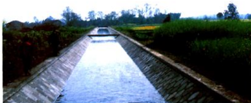
试点工程整治的万星分干渠白土坎段
