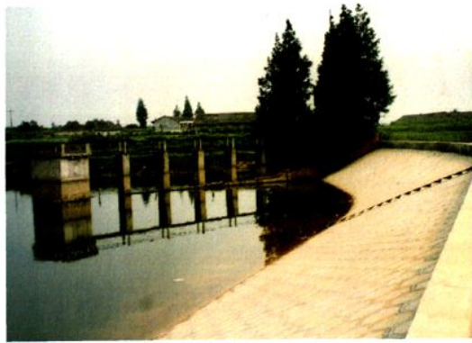
2000年整治后的观音寺水库大坝
