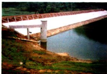
2005年1—5月完成双溪水库内坡和竖井整治
