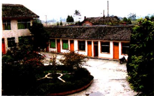
2002年，改造和装修后的新店供水站办公室外境
