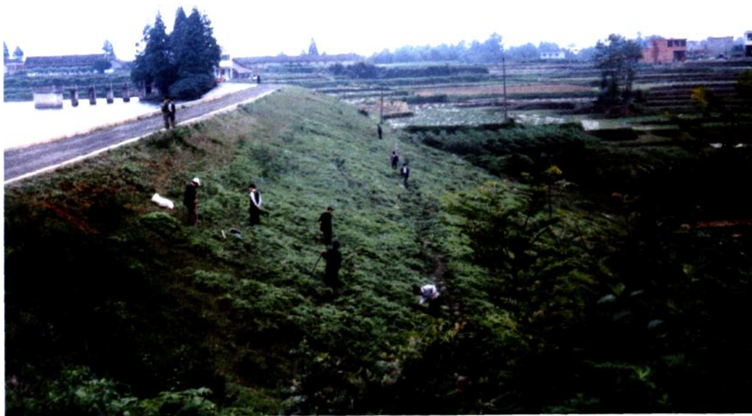
2002年6月，治蚁人员在观音寺水库大坝查找蚁巢，掏沟埋药治理白蚁
