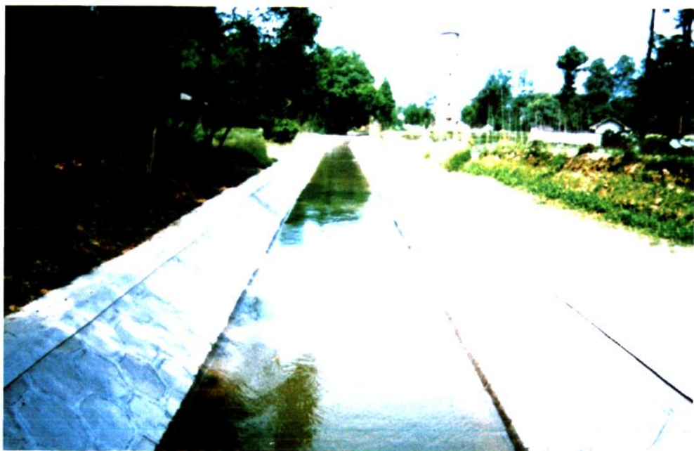
整治后的五星分干渠下段，远处为解放供水站水塔
