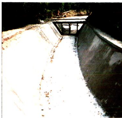
2006年10月，第四期名左渠节水改造项目完成的方家沟段
