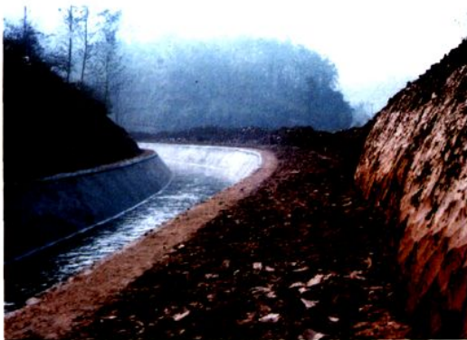
2002年11月第一期节水改造项目整治后的名左渠建山段的部分渠段
