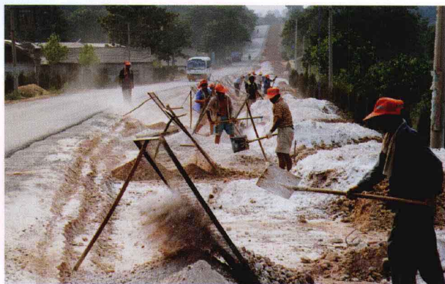
村村通工程施工场景
