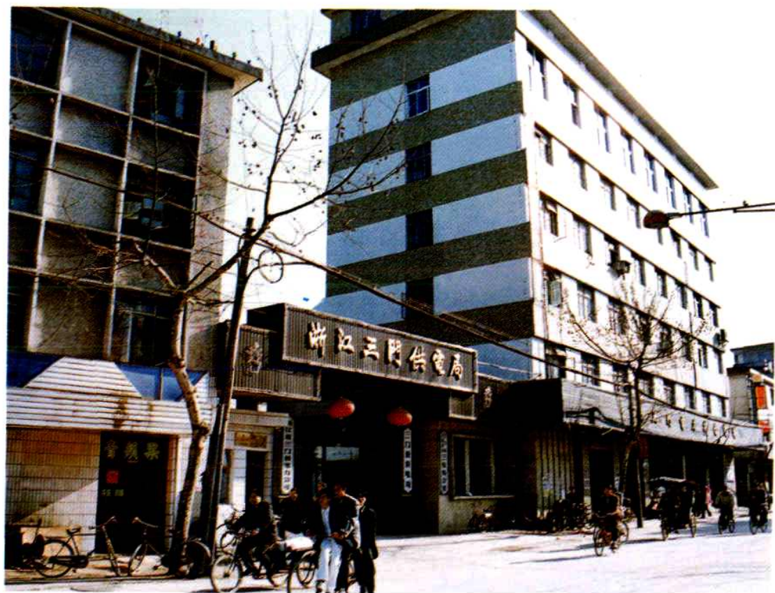
三门县供电局办公楼
