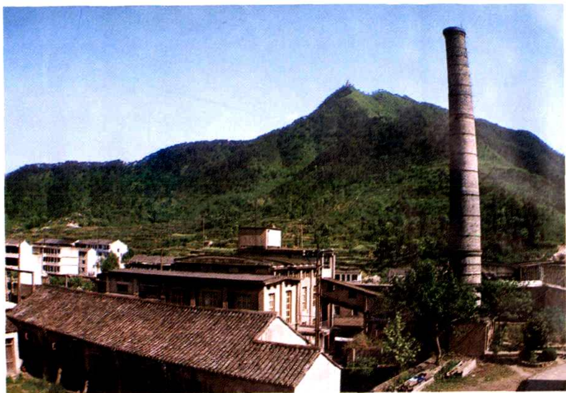
三门电厂厂址一角
