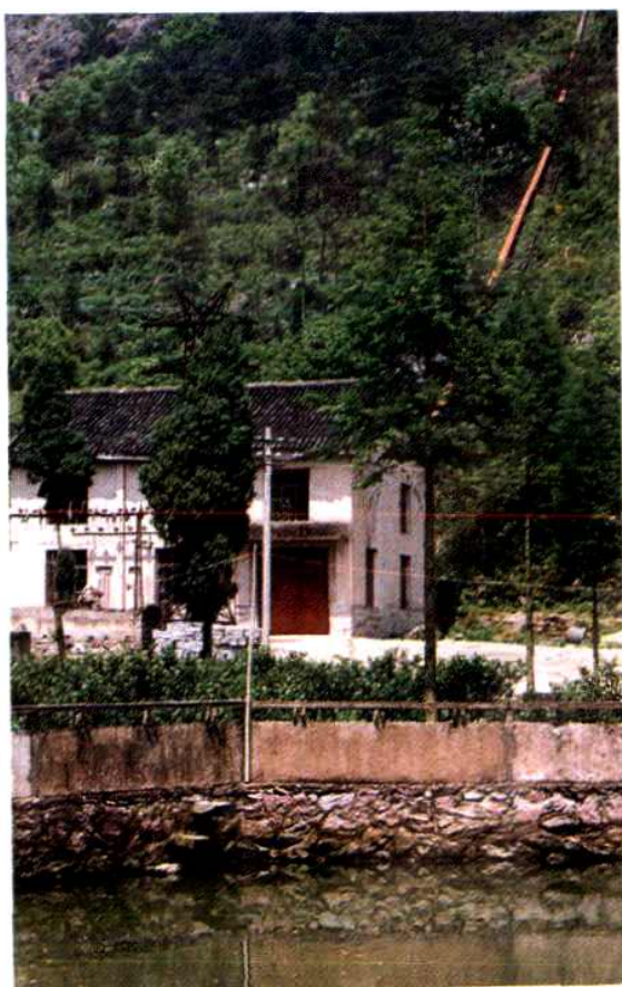
尖坑山水电站
