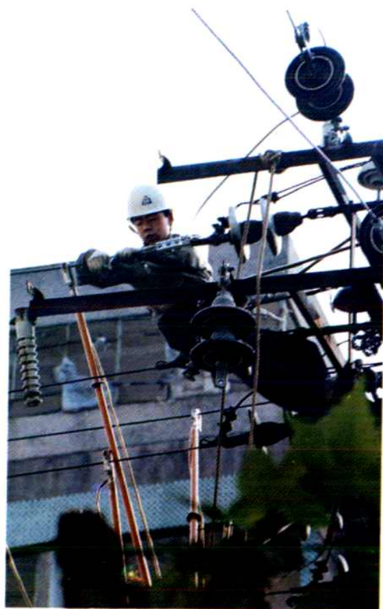
电力职工在检修10千伏线路
