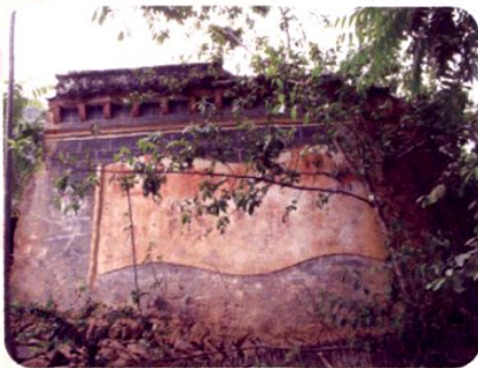
地下党手迹·马家永壁
