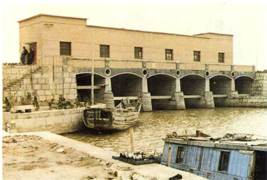
半掘浦排涝闸
