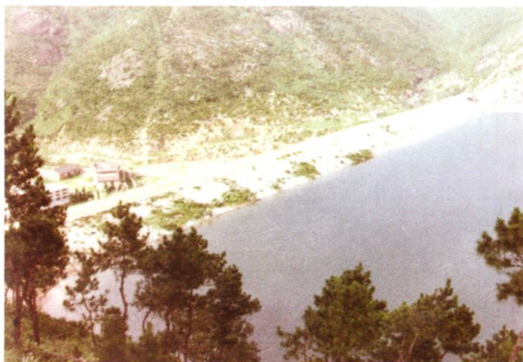
邵岙水库大坝
