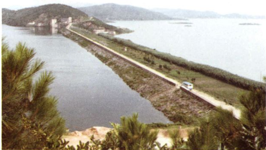
里杜湖水库大坝
