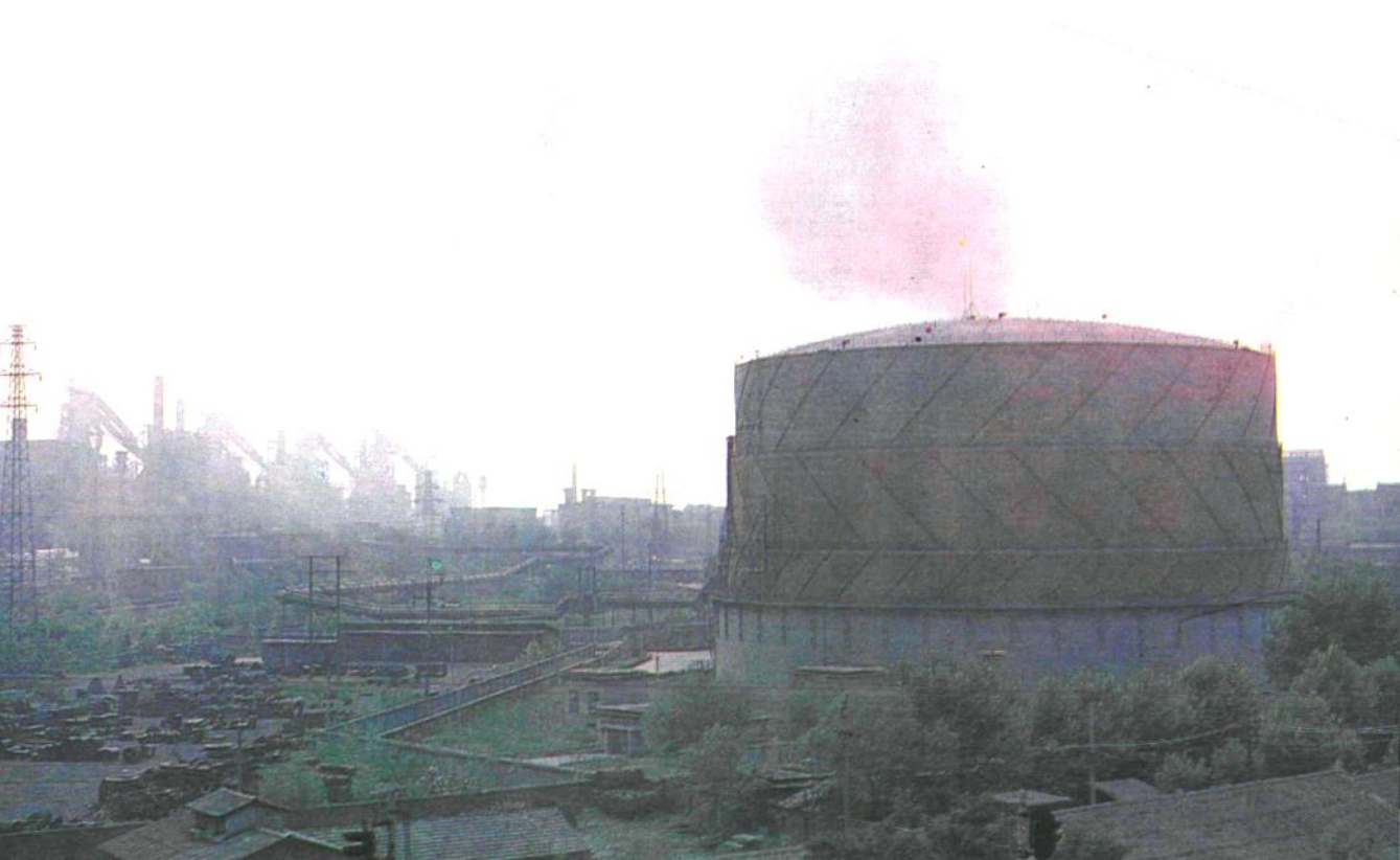
▽武钢 15 万立方米煤气柜
