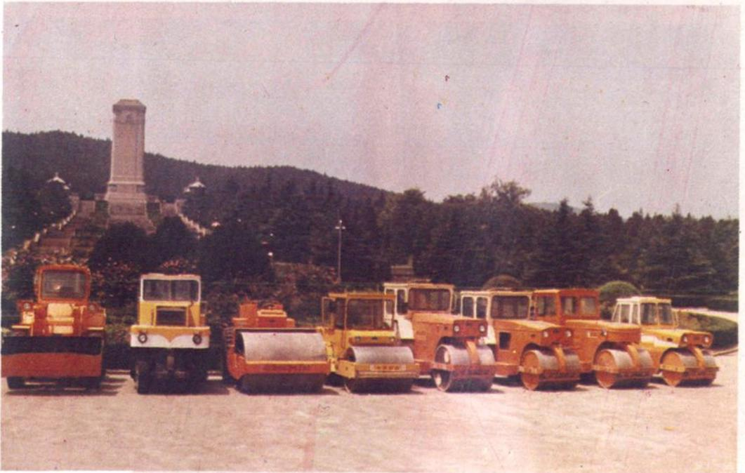
徐州工程机械制造厂生产的各种型号压路机
