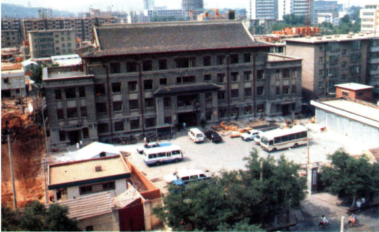
济南市经四路 190 号(现省财政厅旧楼)
