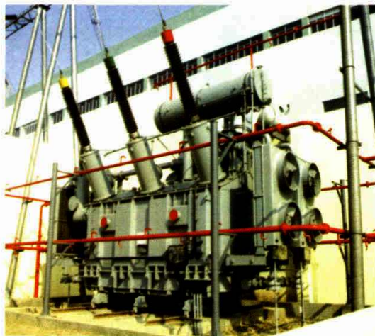
SFP10-170000/220 三相双绕组强油风冷主体 免维护电力变压器
