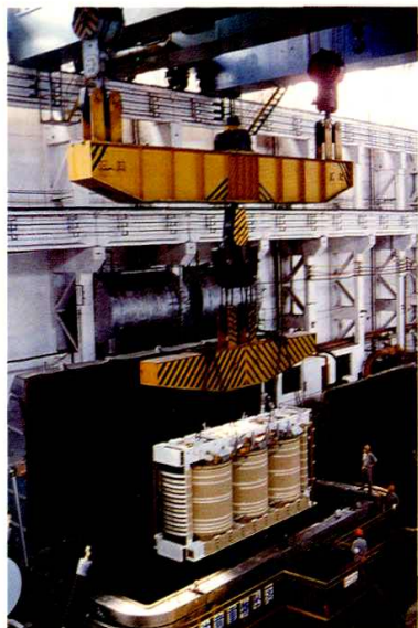
160吨桥式起重机正在起吊大型变压器
