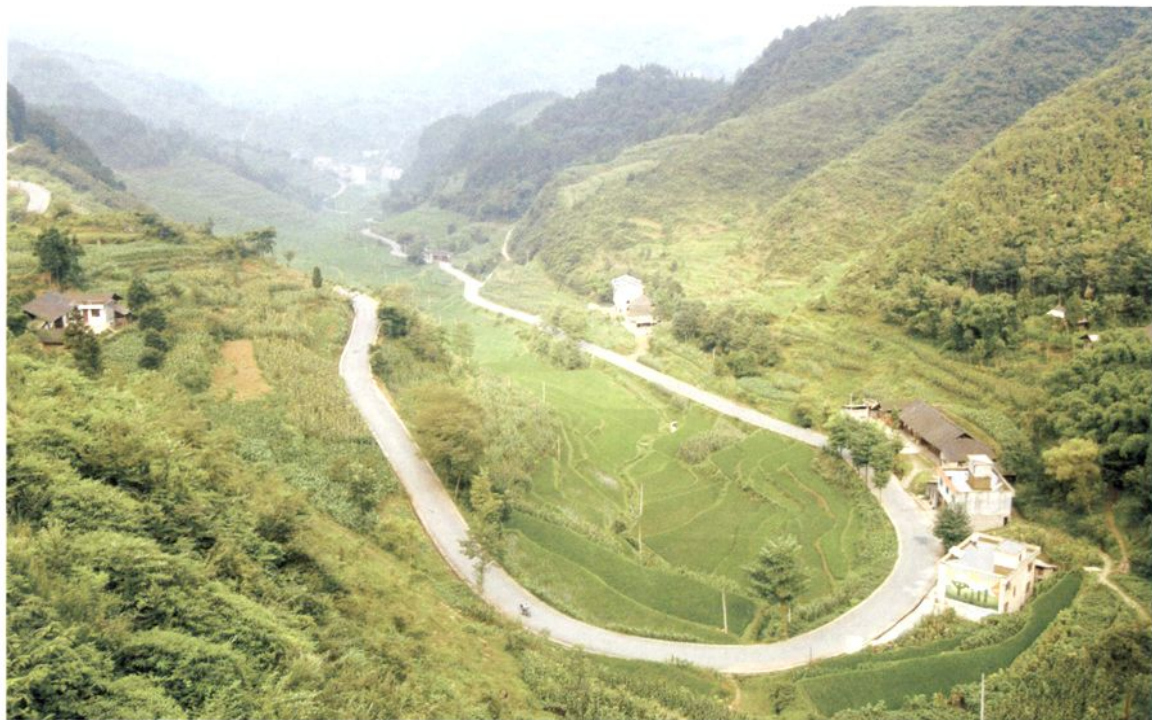
毛混公路田沟段 (图11)
