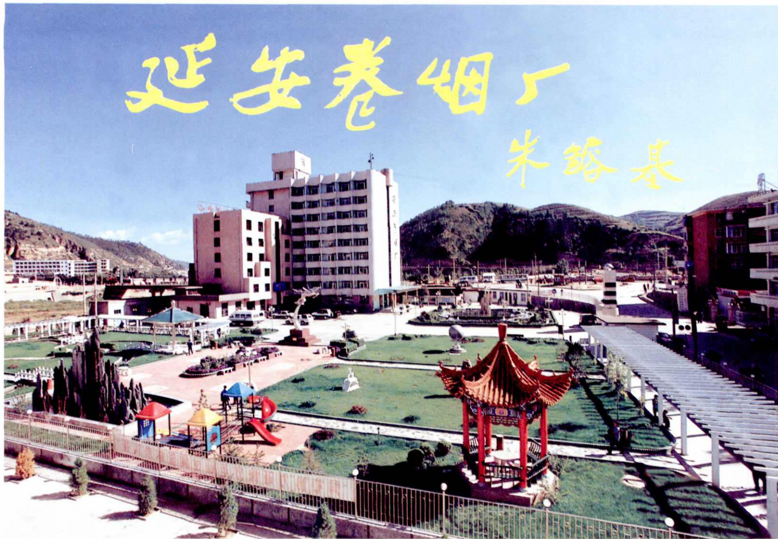
由朱镕基总理题写厂名的延烟办公楼及厂区花园
