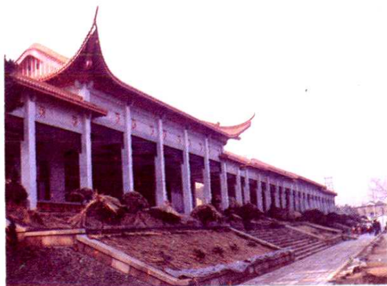
杭州市殡仪馆礼厅
