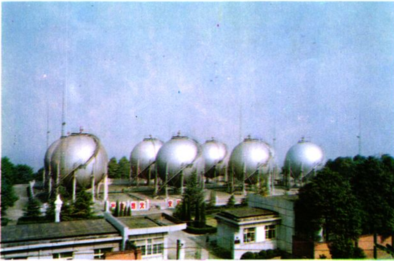
自贡市天然气公司大安储配站
