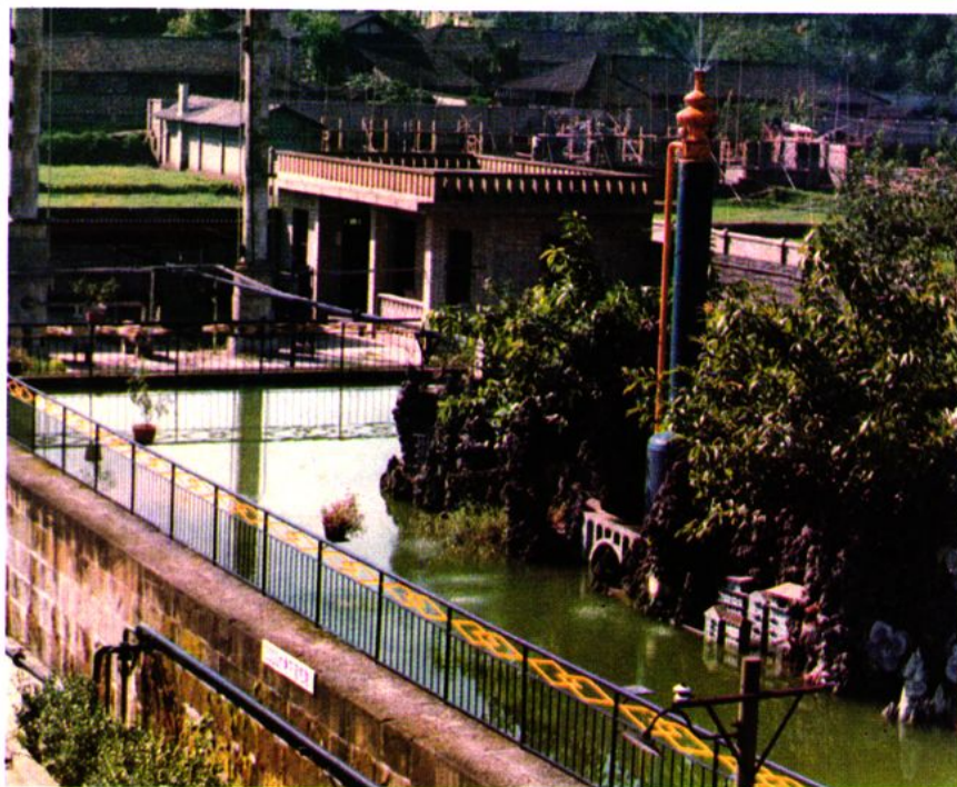
荣县酒厂大型沼气池
