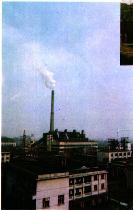
自贡市鸿鹤化工总厂热电站
