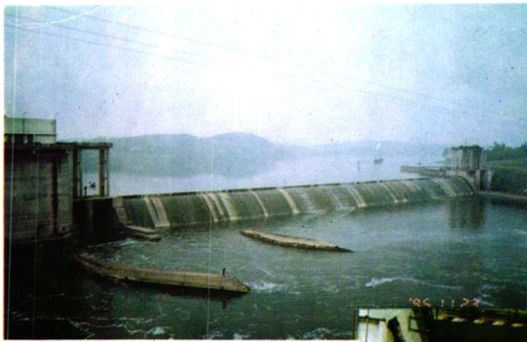
富顺县黄葛滩水电站
