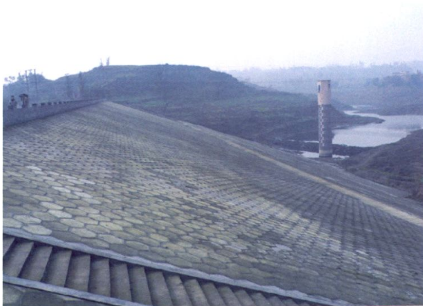
▲整治后的复生桥水库
