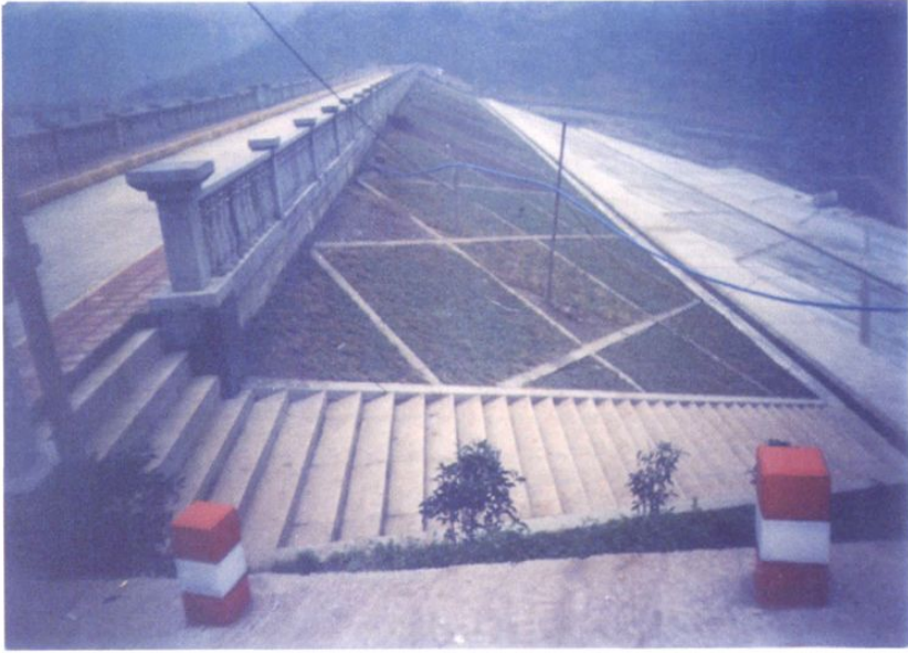
▲除险加固后的关门山水库大坝
