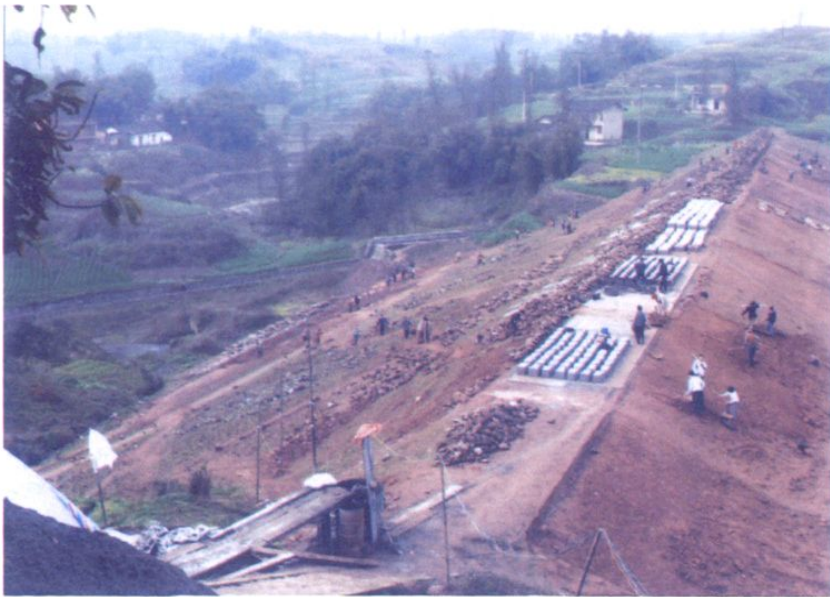
▲复生桥水库整治施工现场
