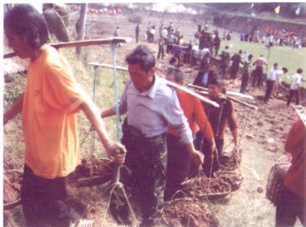
▶ 兴修小型水利工程
