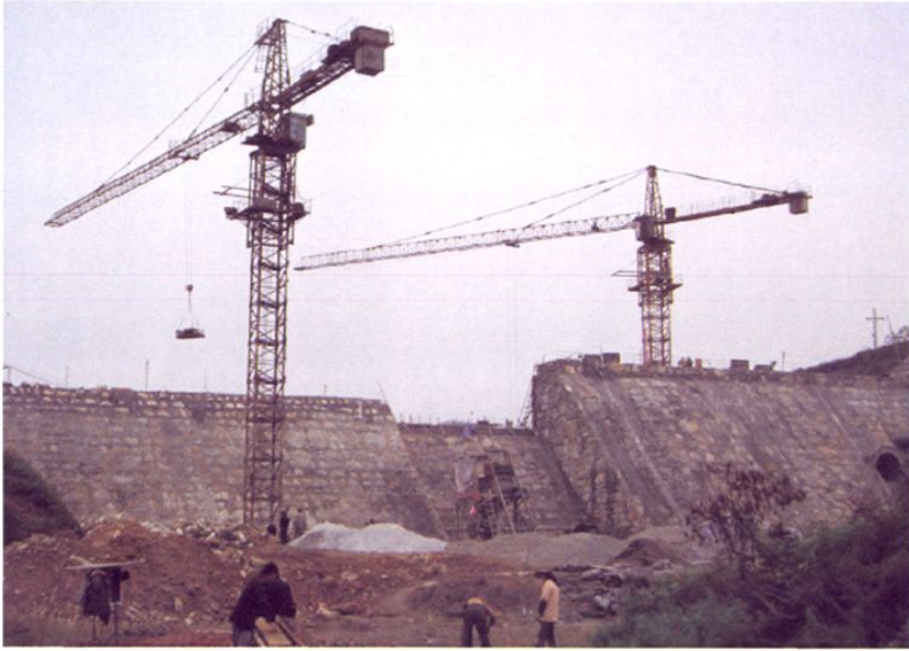
▲建设中的水库大坝
