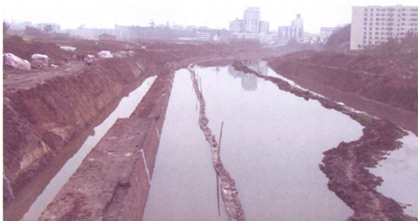
▲跳磴河示范段工程施工现场局部
