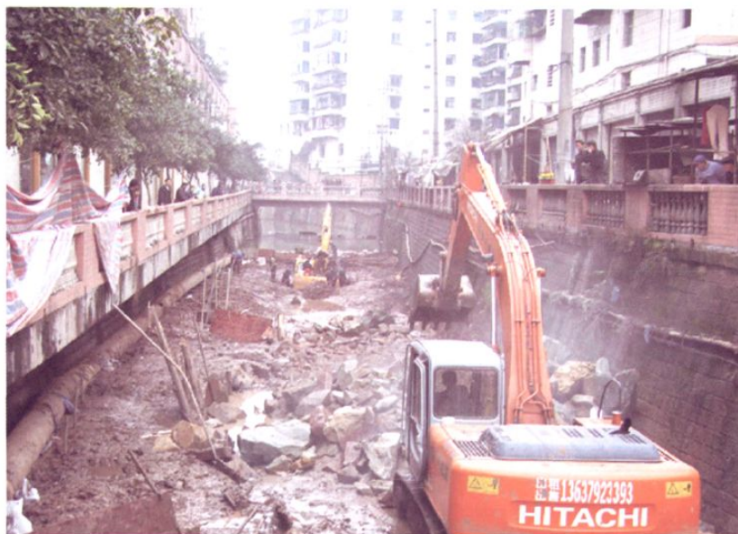
▲城区河道清整施工现场一角
