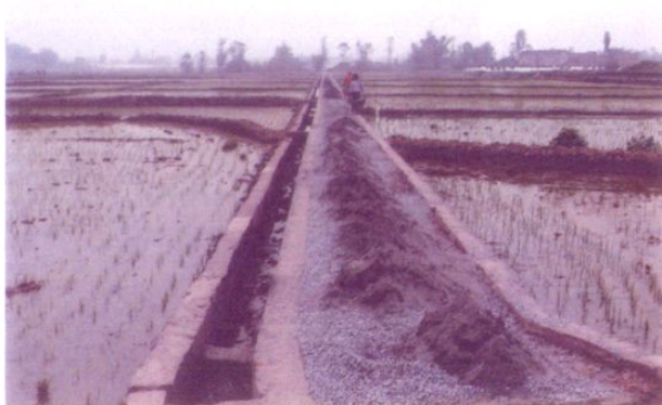
◀ 田间排灌沟及机耕道建设
