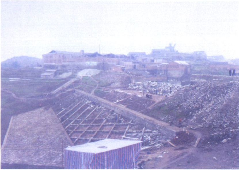
▲断桥水库大坝整治施工现场
