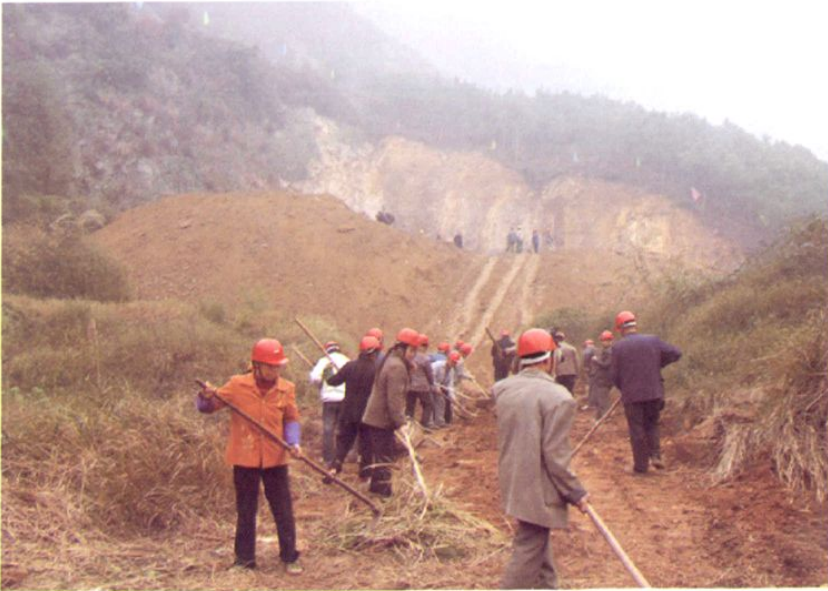
▲松溉长江提水工程黄瓜山隧洞段开工
