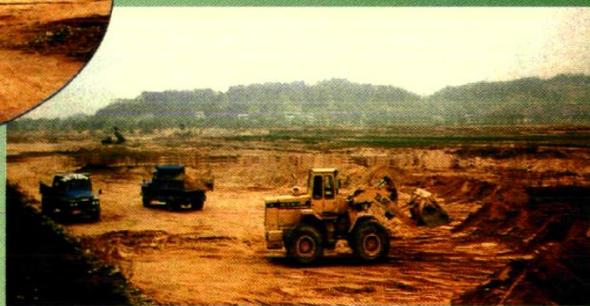
市土地开发中心在英山县南河镇进行土地开发的现场
