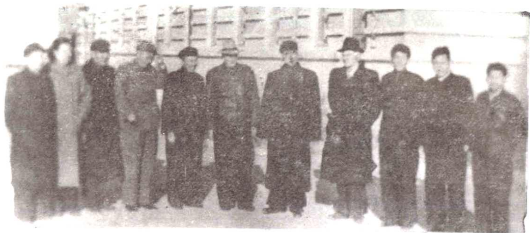
中共中央政治局委员、国务院副总理薄一波于1958年2月视察公司 富拉尔基热电厂建设工地
