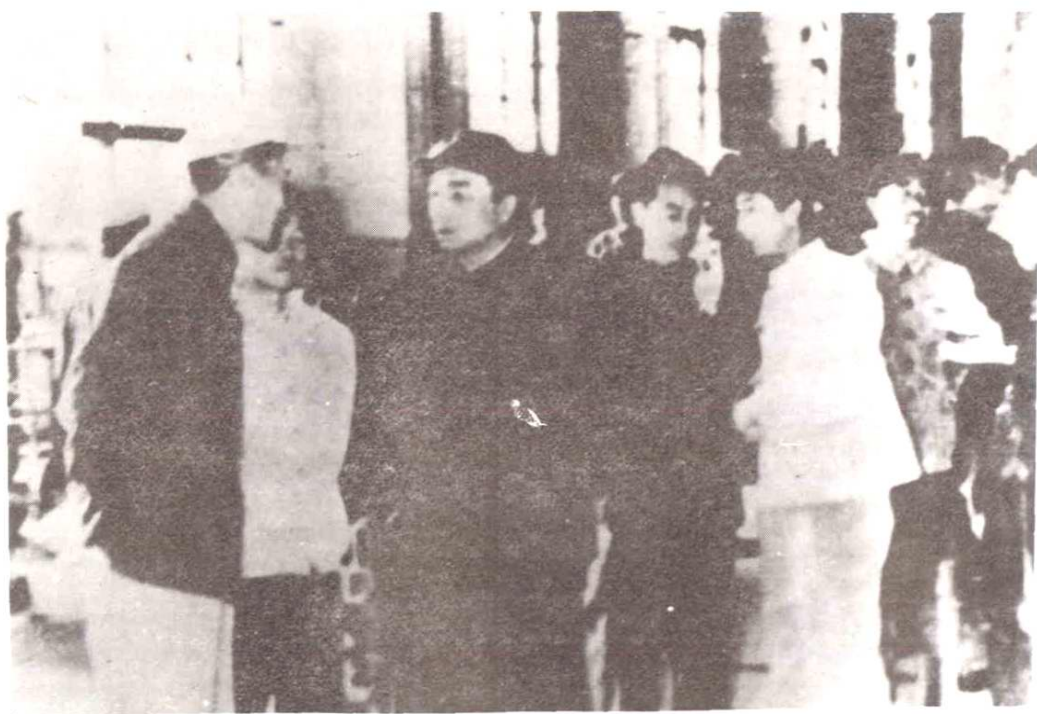
中共中央政治局委员、国务院副总理彭德怀于1958年6月视察公司 富拉尔基热电厂工程工地
