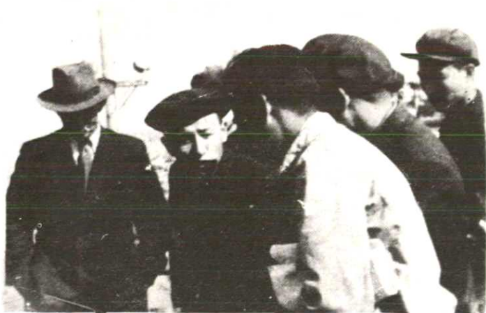
► 中共黑龙江省委书记冯纪新（左二），于1954年5月在公司富拉尔基热电厂施工现场检查工作
