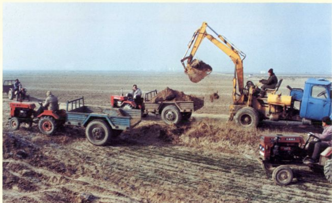
罗四拔村省级盐碱地土地开发项目现场
