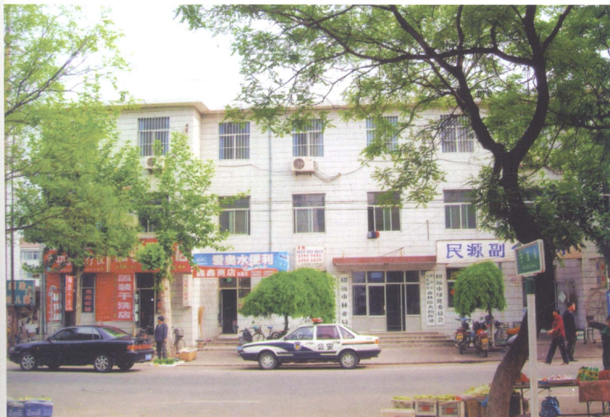
招远市林业局办公大楼
