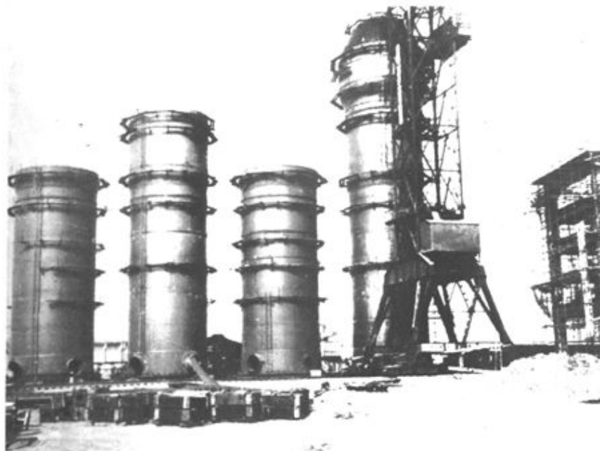
正在建设的唐钢1260米 3 高炉的四座热风炉
