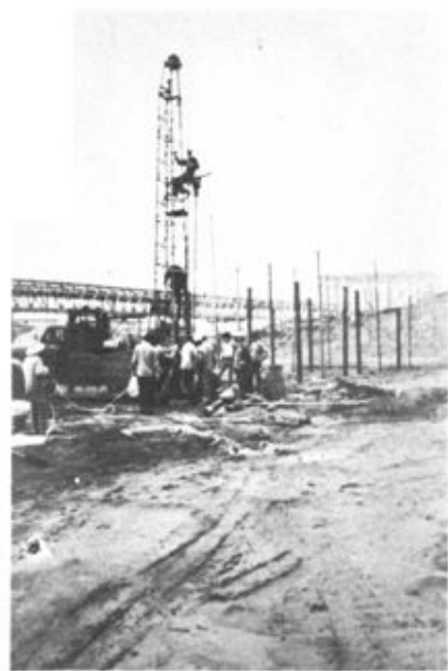
武钢工业港原料场进行 堆载试验
