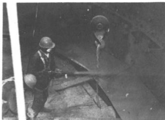
高炉保护层喷涂施工
