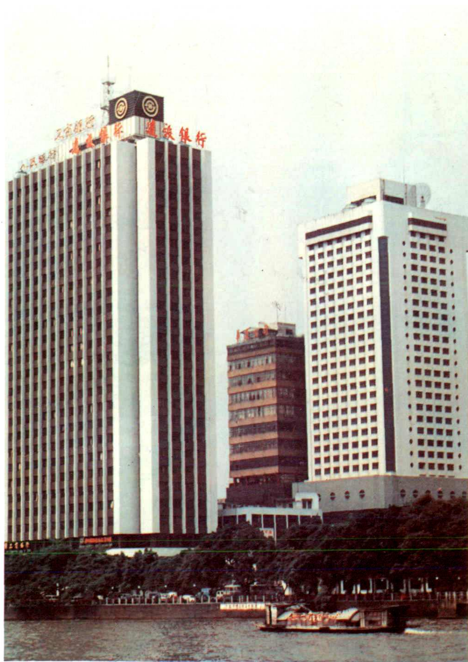
广东省人民银行、广州市建设银行营业楼
