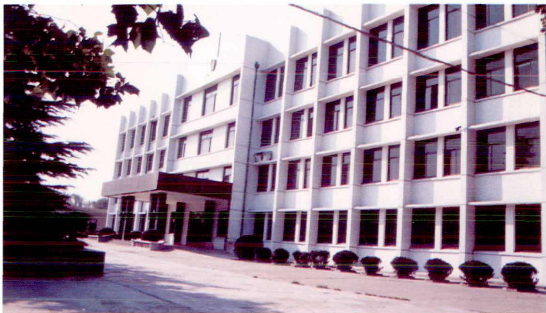
石横镇机关办公大楼
