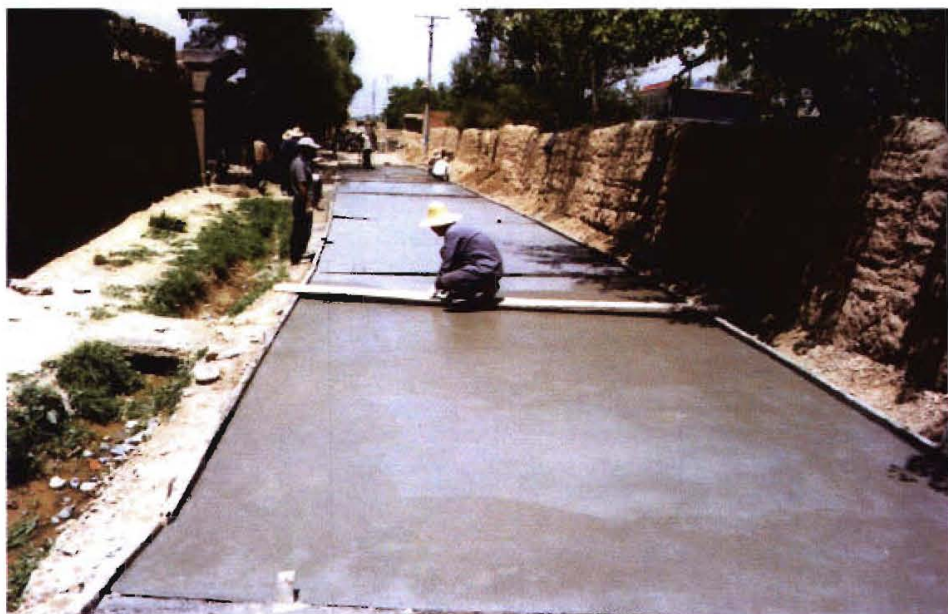
村级道路硬化
