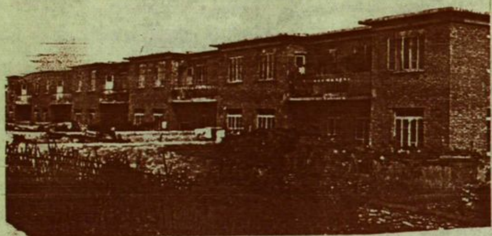
矿科技干部家属住宅楼
