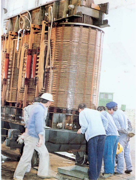
▷ 检修变压器(秦昌展摄)
