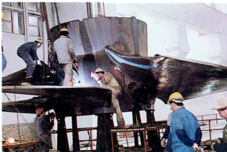
▽ 安装水轮机转轮(秦昌展摄)
