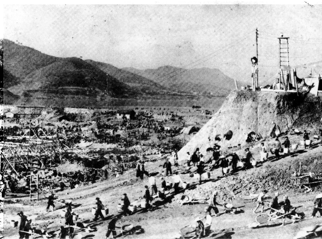
△ 1959年西津水电站一期土石木笼围堰工程施工
