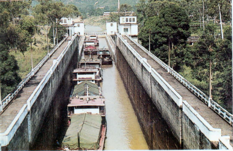
▽ 设计可通航 2 \times 1000 吨级船队的西津船闸，1966年元月建成通航 (秦昌展摄)
