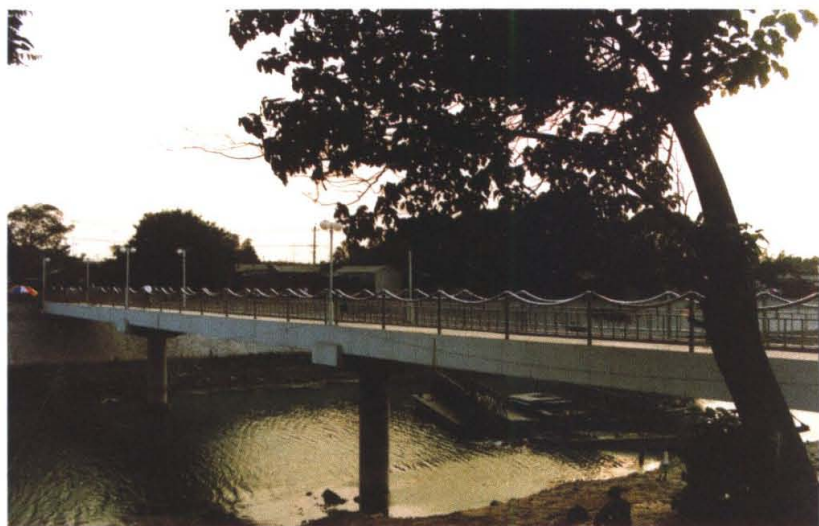
2001年，在蔺家渡口上架起钢筋混凝土桥梁。
