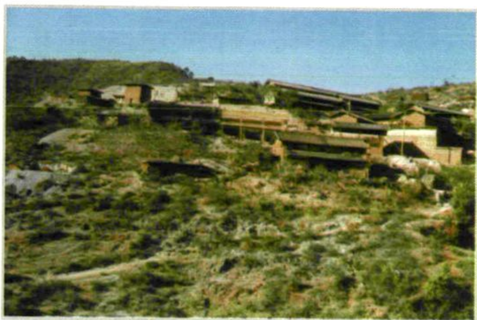
小街乡普厂村挖山建房一瞥。
