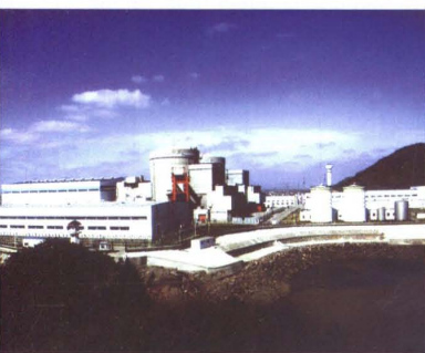
秦山二期核电站全貌
