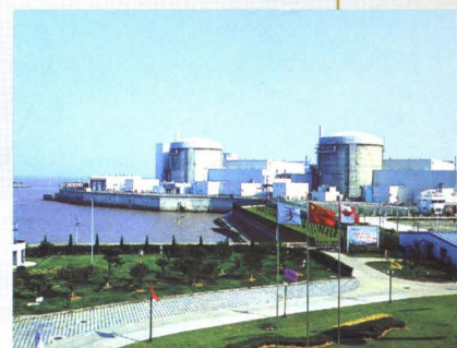
秦山三期核电站全景
