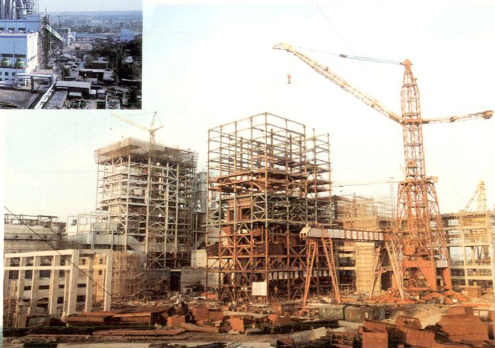
技改工程建筑工地
