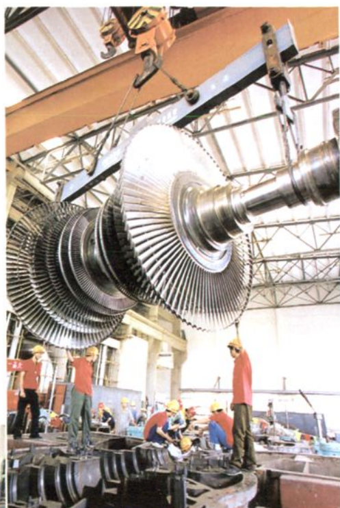
汽轮机安装现场
