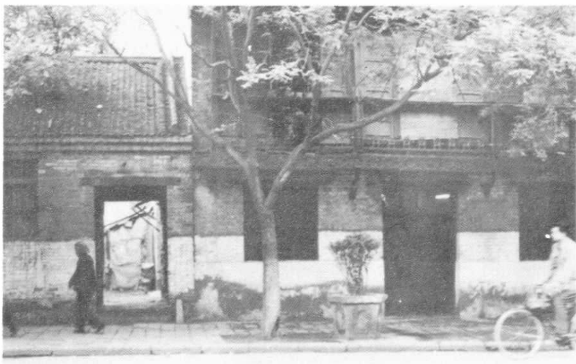
1953年10月 18日成立河南省 中医院,地址在 开封市自由路47 号
