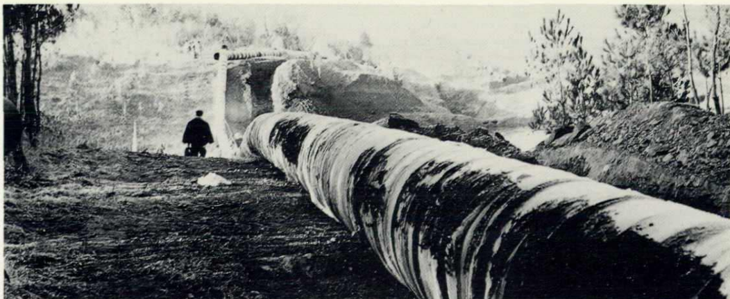
公司承建的魏荆 (河南魏岗—湖北 荆门) 输油管线
