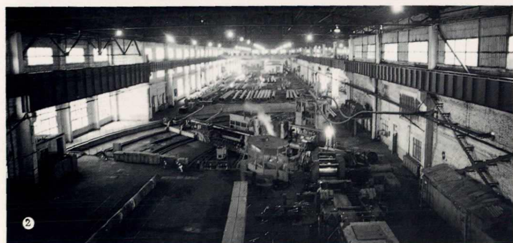
1、职工人拉肩扛 抢建工程 2、公司建成的沙 市制管厂内景
