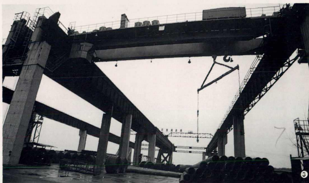
3、公司承建的长江 沿岸最大的桥式 装卸码头——湖 北沙市码头
