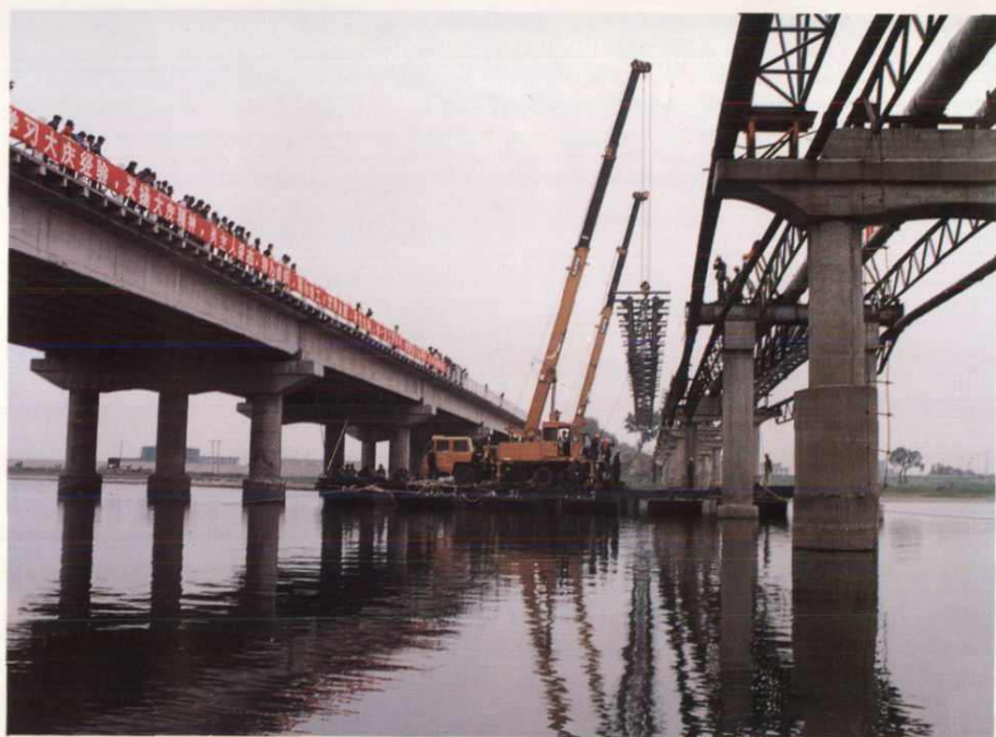
舟桥水上吊装
