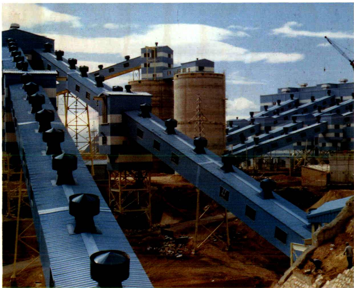
正在建设中的平朔安太堡露天煤矿选煤厂
