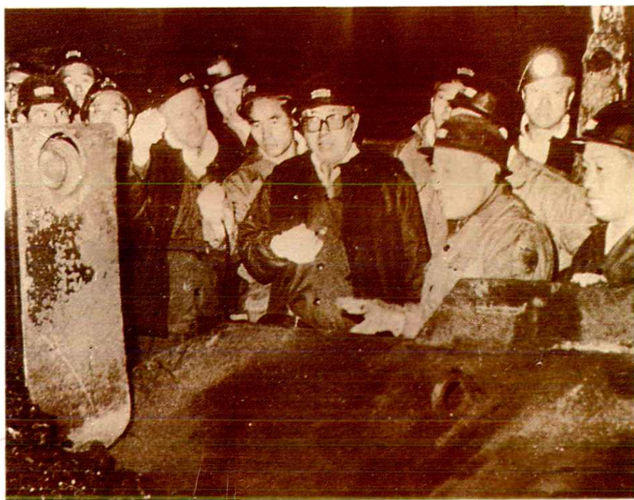
1982年8月22日煤炭工业部部长高扬文在大同矿务局大斗沟矿视察乔依掘进机组
