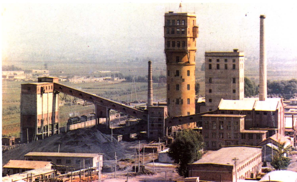
立井施工采用 多种新技术
