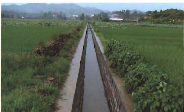
浆砌石排洪渠
