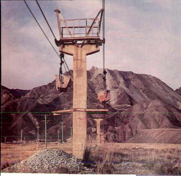
全长 11.7 千米的西沟石灰石矿 架空运输索道（酒泉钢铁公司）
