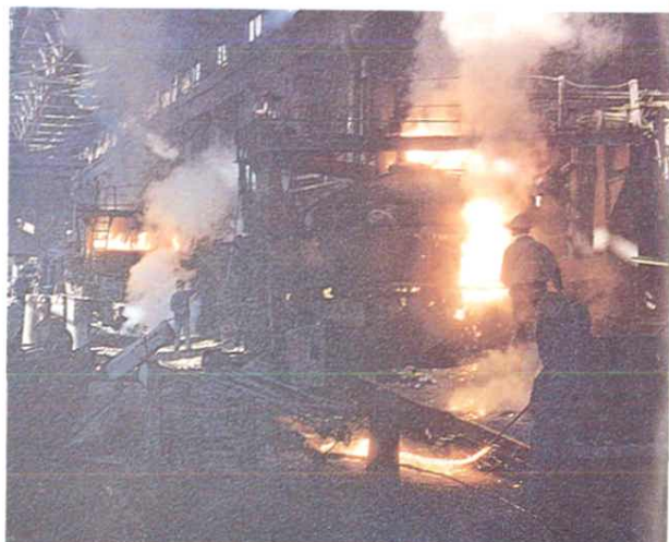
兰州钢厂电炉炼钢车间及正在生产的5吨电炉
