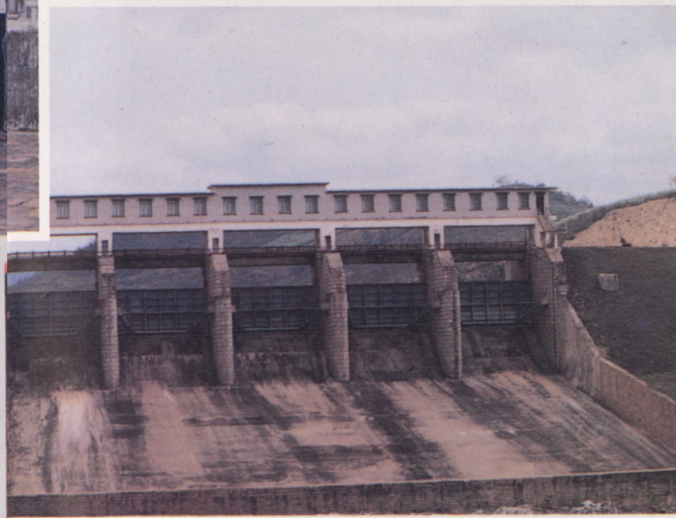
▼石碌水库溢洪道
