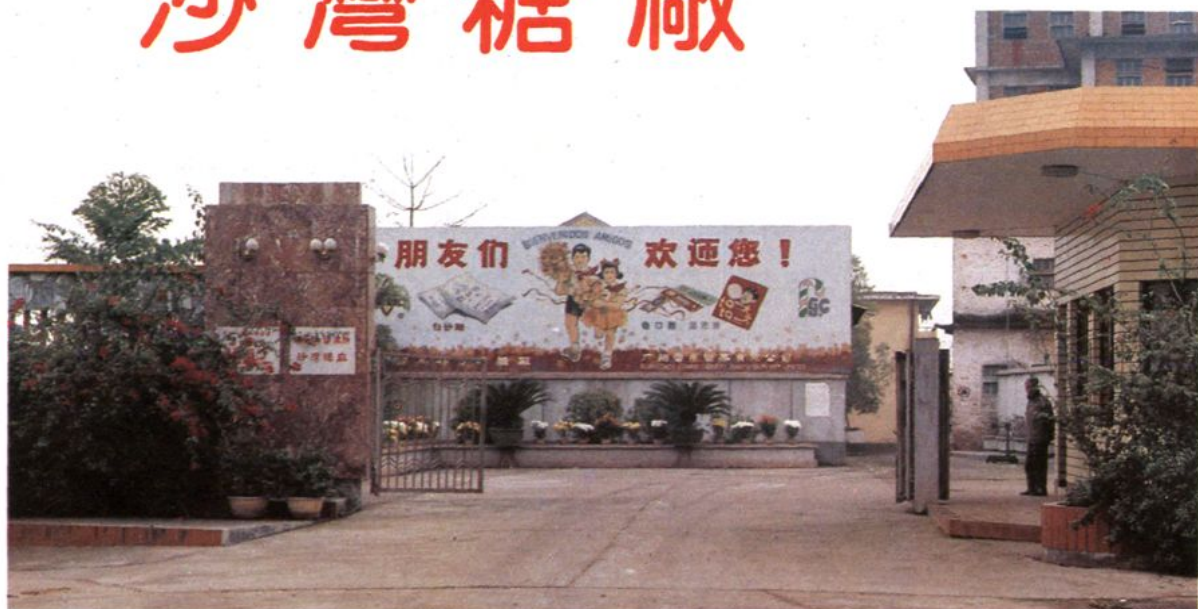
88年改建的新廠門。
