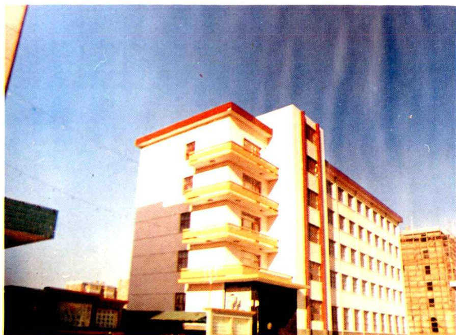
绥化电业局综合大楼外貌
