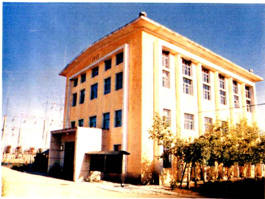
1977年竣工的绥化一次变电所主控楼，1981年投入运行。
