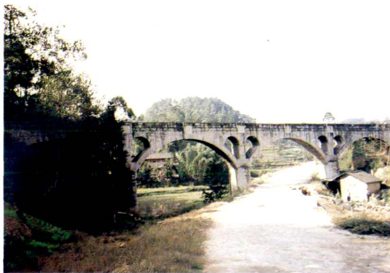
三岔河水库茅家沟渡槽
