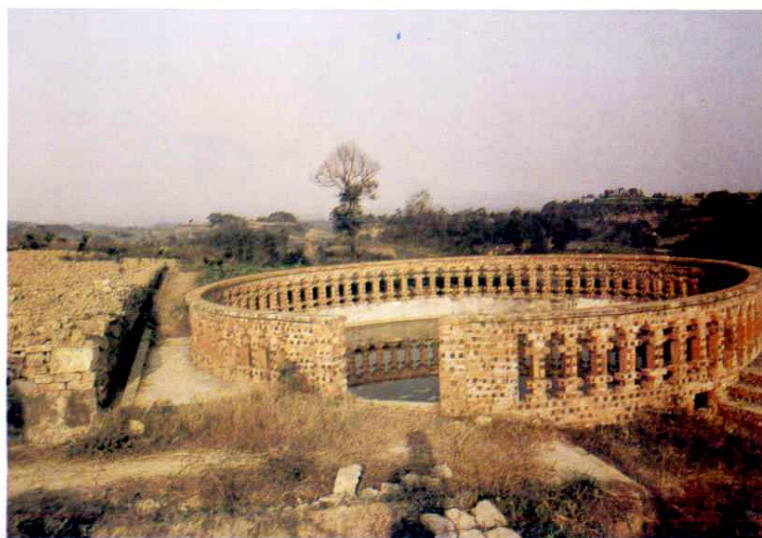
山岔河水库节雨集灌工程
